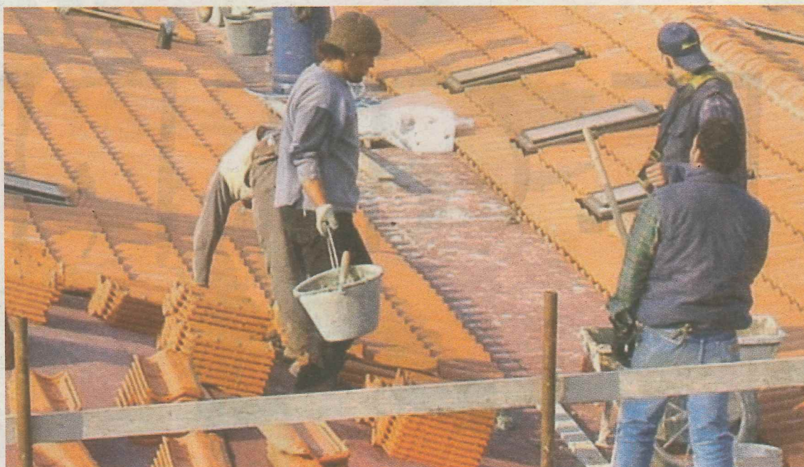
Operai al lavoro in un cantiere edile
