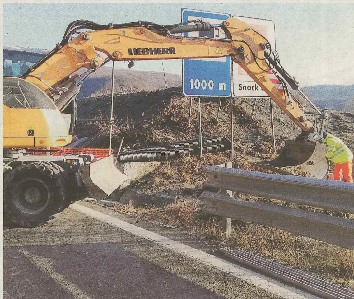
Lavori sulla E45
